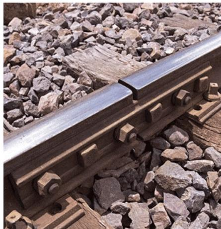
(圖八)鐵軌的預留縫隙
