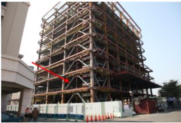
(挫屈束制支撐構架/圖片出處國家實驗研究院)
