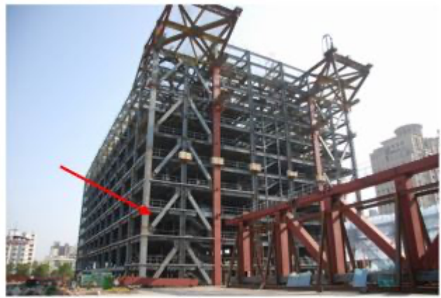
(挫屈束制支撐構架/圖片出處國家實驗研究院)
